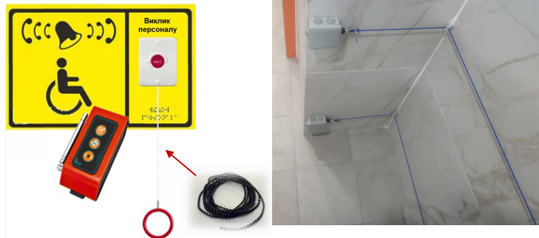
Кнопка виклику в універсальному сан.-гіг. приміщенні
