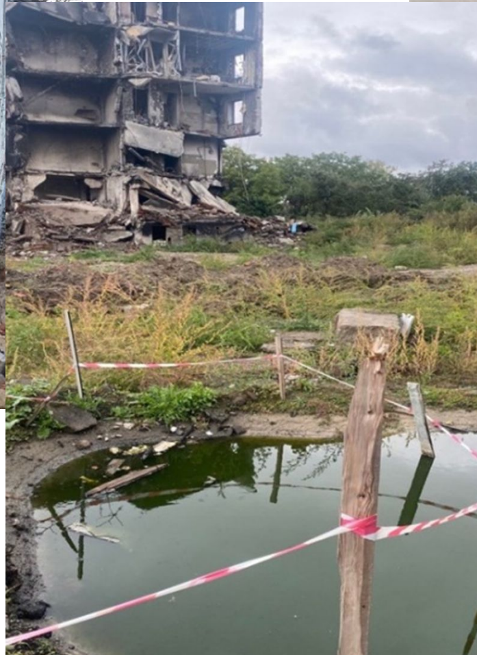
Очисні каналізаційні споруди
