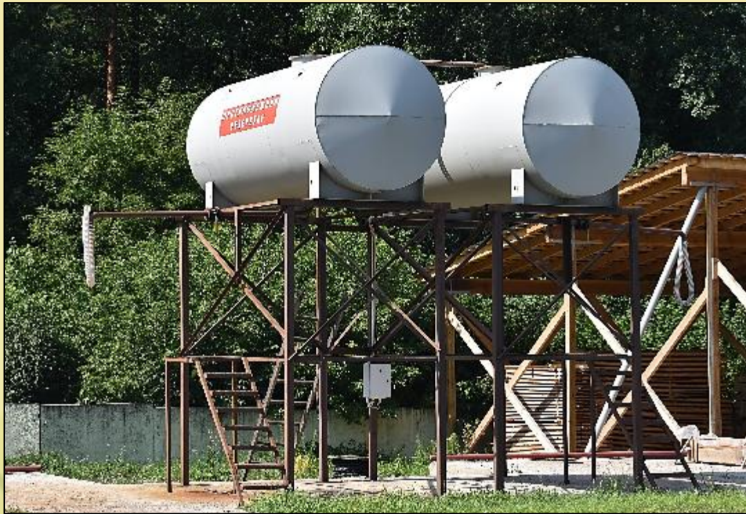
Пожешна розливна станція з автоматичною подачею води від свердловини до ємностей (2x10 м 3 )
