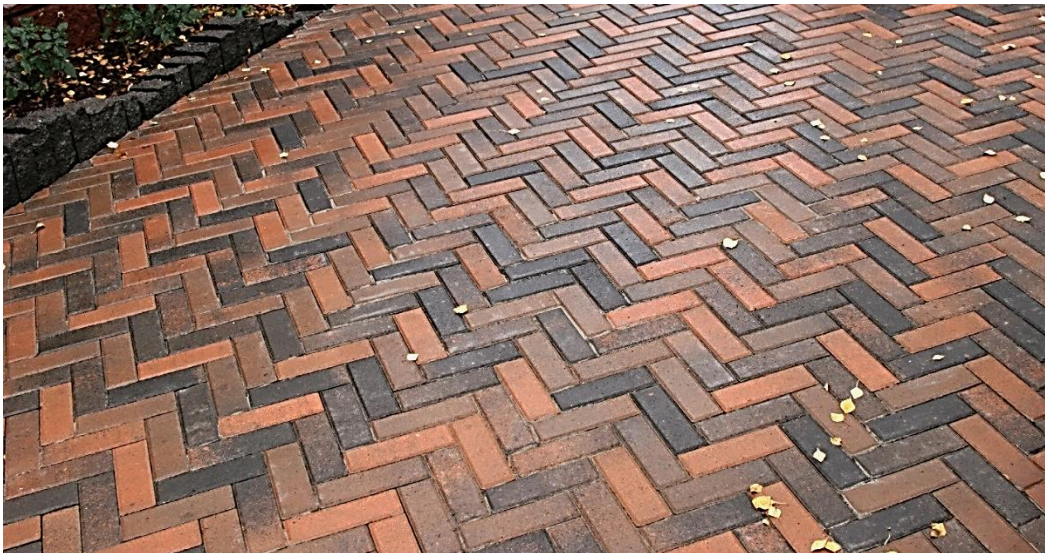
Рис. 8. Укладка ФЕМ способом «паркет»
