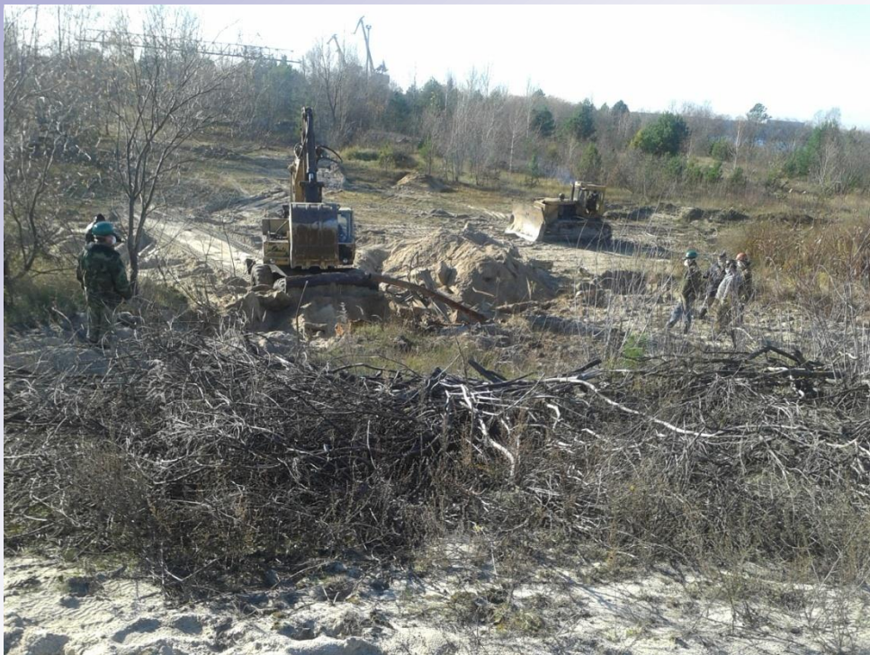
Роботи з перезахоронення траншей ПТЛРВ “Нафтобаза”.
